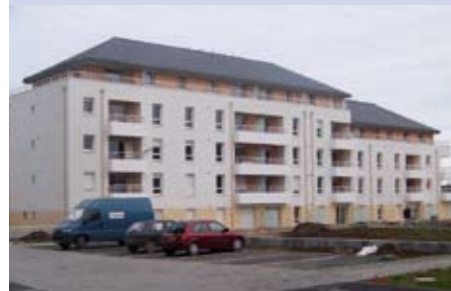
L'immeuble de 27 appartements rue Georges Le Sant sera livré au premier trimestre. Les attributions sont en cours. L'aménagement du cœur d'îlot est en cours.
