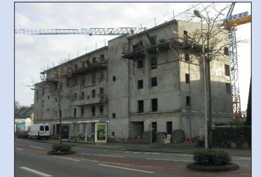
Construction en cours
