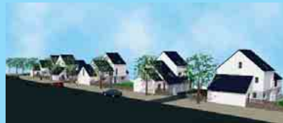
Construction de 10 pavillons individuels et d'un petit collectif, avenue Marianne
