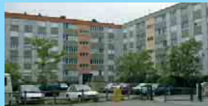
Démolition immeubles rue G. Le Sant
