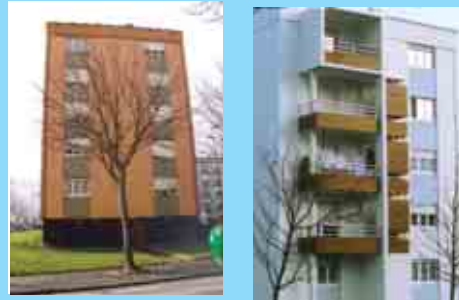
avant après travaux rue de Kervénanec
