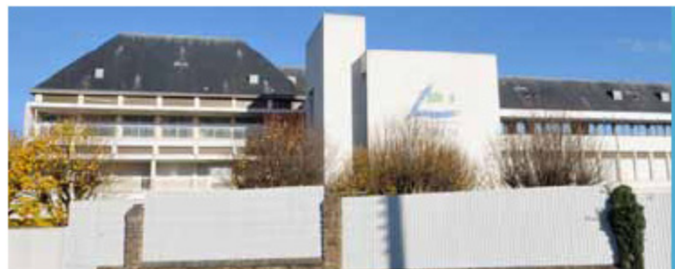
Les prochaines déconstructions sont prévues pour le printemps prochain.
