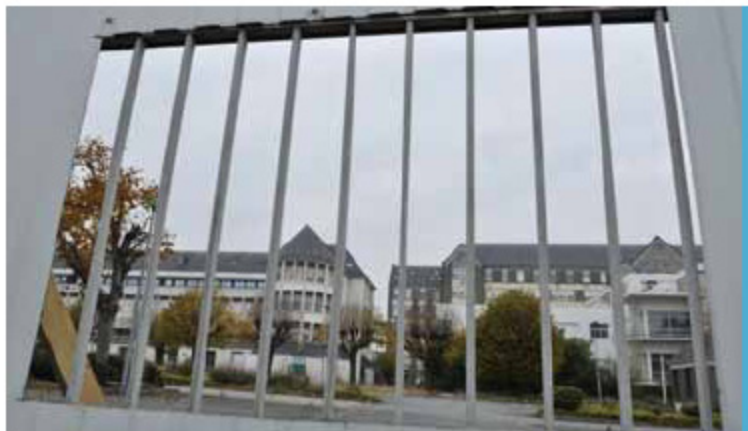
La déconstruction des bâtiments est programmée jusqu'à la fin 2015.
